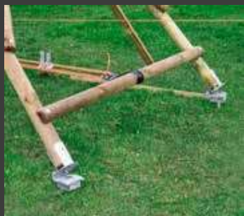
Kantówkę zamontowaną do stałych profili montażowych, mocujemy do ruchomych kotew gruntowych. Po zamontowaniu podnosimy podbudowę w sposób ukazany obok.
