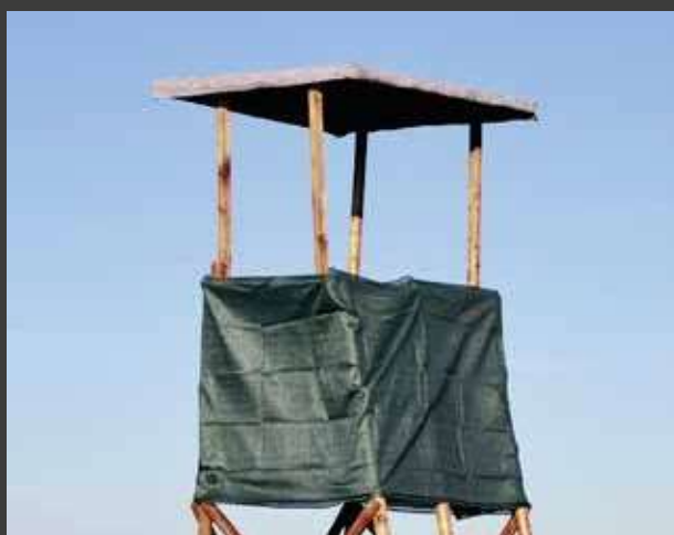
Konstrukcja dachu 140 x 140 cm z czterema słupami i siatką maskującą – ma tę zaletę, że umożliwia celowanie do stojącej zwierzyny z dużej odległości.
