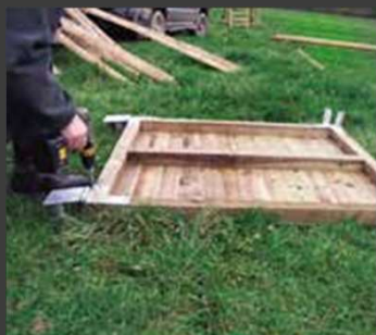
Profile montażowe są przykręcane do podłogi wieży
