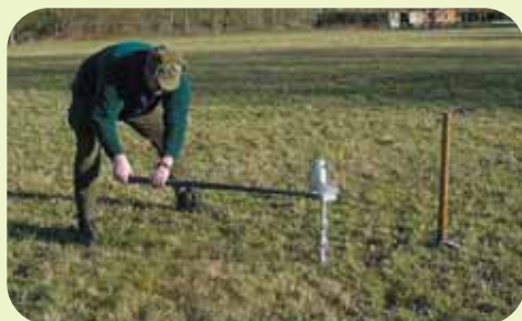
Bei sehr festem Boden verwenden Sie zum Eindrehen eine Eisenstange.
