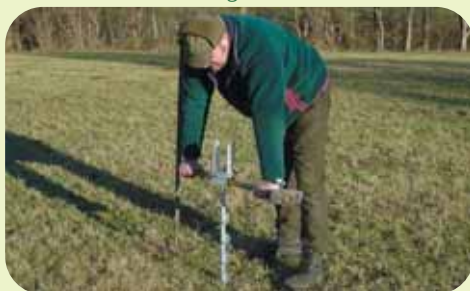
Nach dem Vorstechen, kann der Schraubanker wie abgebildet eingedreht werden.
