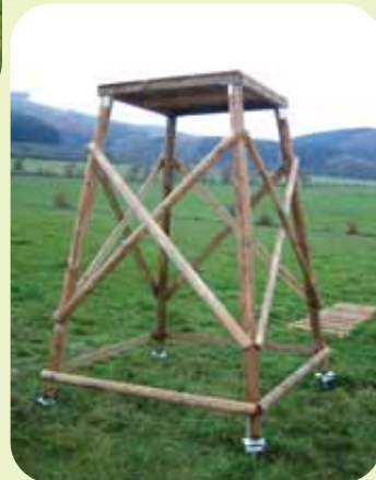
Im bergigen, offenen Gelände reicht der Unterbau 240 cm hoch oft aus. Die Montage ist einfach.
