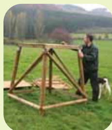
An manchen Plätzen, oft unter großen Bäumen, reicht ein Unterbau von 150 cm Höhe. Die Montage ist einfach.
