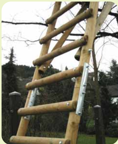
Detail Teilung der Leiterelemente
