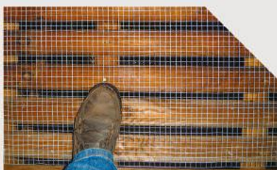
▲ Zabezpieczenie przed poślizgiem
