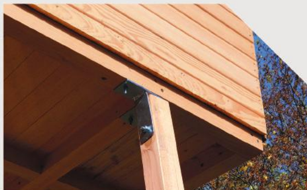
▲ Profil mocujący podłogę
