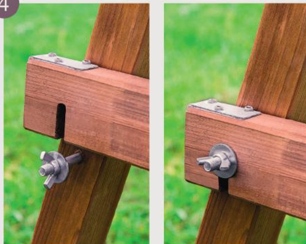
Zatrzaśnięcie połączeń śrubowych
